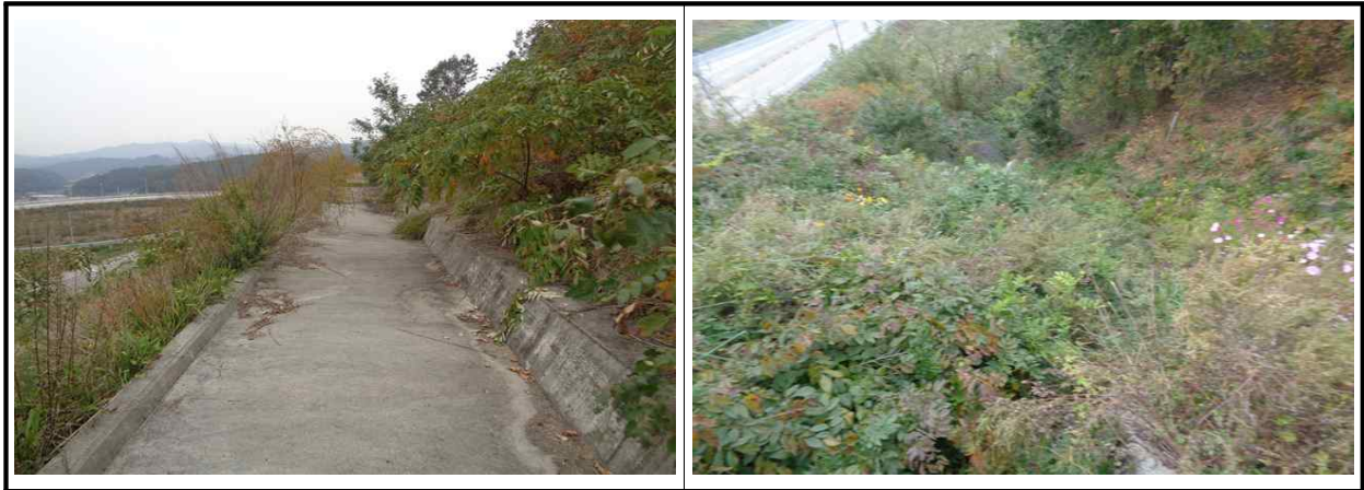
【그림 11.3.3】 배수시설 전경
